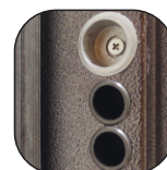
Эксцентрик для регулировки прижима дверного полотна
